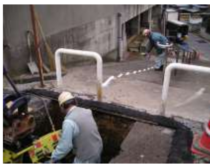
フレックスドリル施工状況①
