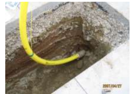
配管引抜き状況
