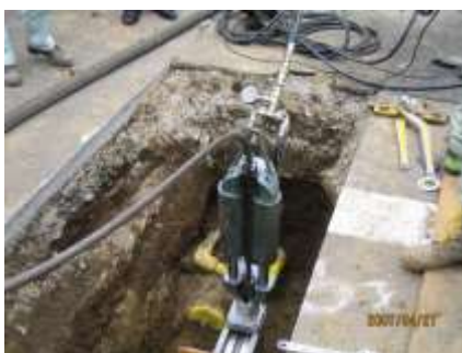
トリックトレンチレス設置状況
