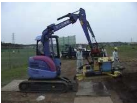
フレックスドリル接続状況
