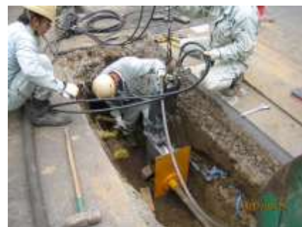
トリックトレンチレス施工状況
