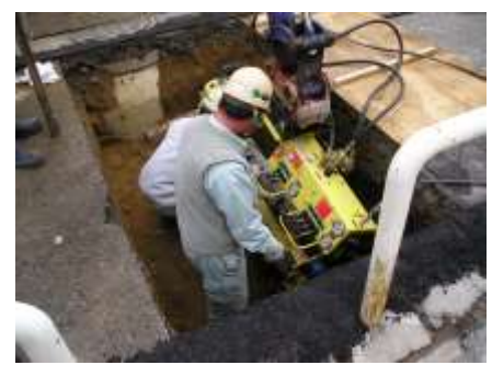
フレックスドリル施工状況②
